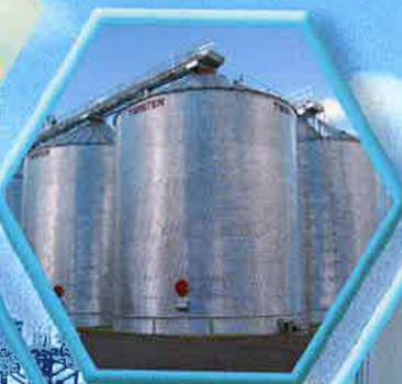
穀物筒倉 Grain Bin (鍍5%鋅產品 Galfan) ▲ 照片由加拿大Twister Pipe公司提供 Courtesy of Twister Pipe Ltd., Canada
