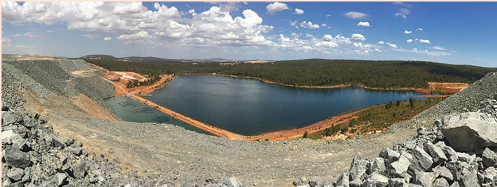
Tambang Boddington Newmont di barat-daya Western Australia. Tambang memisahkan air berpotensi terkontaminasi, yang dikeringkan dari pembuangan limbah dari fasilitas penyimpanan air baku di latar belakang. Air dipompa kembali ke pabrik pengolahan untuk digunakan terutama dalam penempatan air baku.
