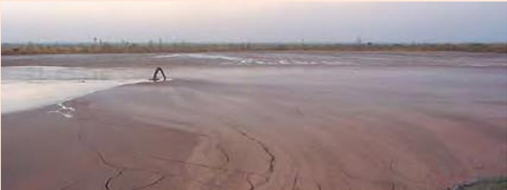
*Menciptakan profil cembung penapisan curah hujan dengan pelepasan tailing kental yang terpusat ke dalam Bullakitchie Pit.*
