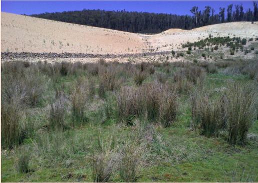
*Aliran air anaerobic (kosong oksigen) vertikal dari bawah ke atas ke bagian hulu wetland (lahan penuh air) dari tanggul TSF.*
