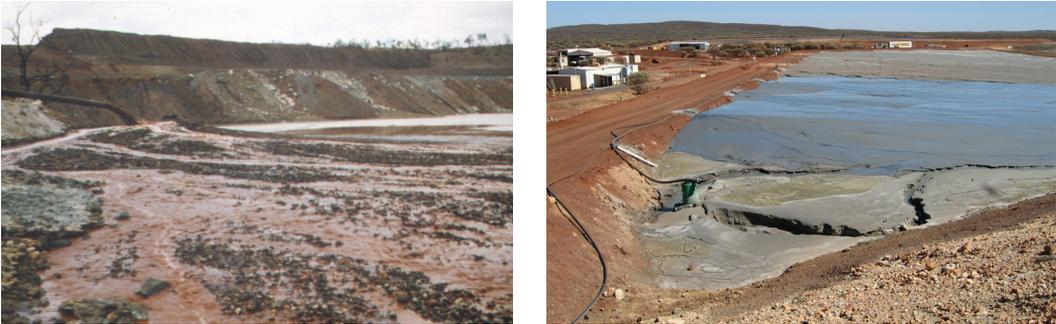
Gambar 32: Pencungkupan timbunan tailing secara bertahap menggunakan peralatan skala kecil: (left) menambah timbunan tailing dengan menggunakan truk-truk kecil; (kanan) mendorong tambahan dalam tumpukan tipis dengan menggunakan D6 Swamp Dozer
