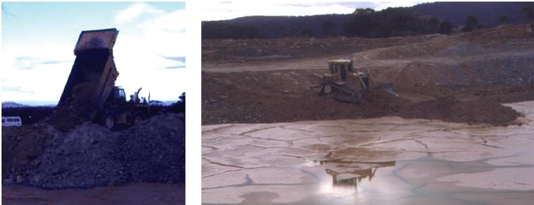
Gambar 33: Pencungkupan timbunan tailing: (kiri) menyebabkan kegagalan gelombang haluan karena peralatan berskala besar; (kanan) kerusakan eskavator pada lapisan penutup yang terlalu tipis atas tailing lembut
