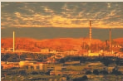
Altos hornos de cobre de Xstrata en Mount Isa Mines—alto horno de cobre (chimenea en rojo y blanco) y planta de ácido (chimenea blanca)
