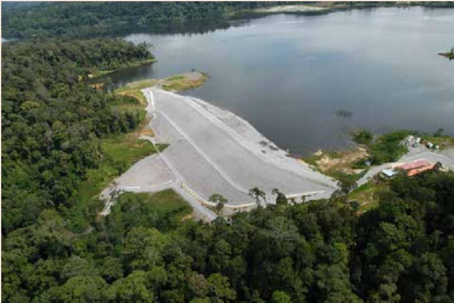
*Gambar 2: Area penyimpanan tailing Namuk memperlihatkan tanggul yang dibangun*
