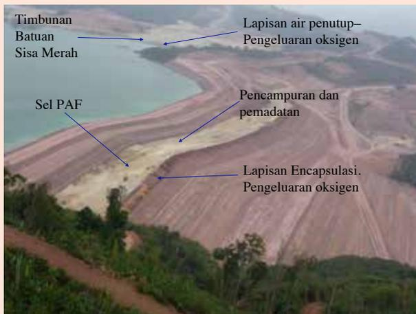
*Gambar 1: Tanggul TSF memperlihatkan lokasi sel PAF di bagian hilir dari dinding bendungan dan Timbunan Limbah Jalan Merah yang terletak di dalam daerah tangkapan TSF*
