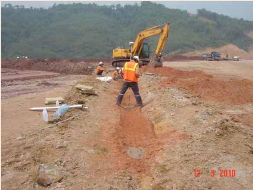
*Gambar 4: Pemasangan sistem pemantauan gas pori horizontal*
