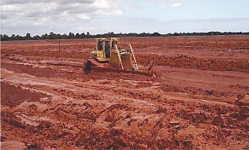
*Uso de una excavadora de pantano D6 para aumentar la velocidad de secado.*
