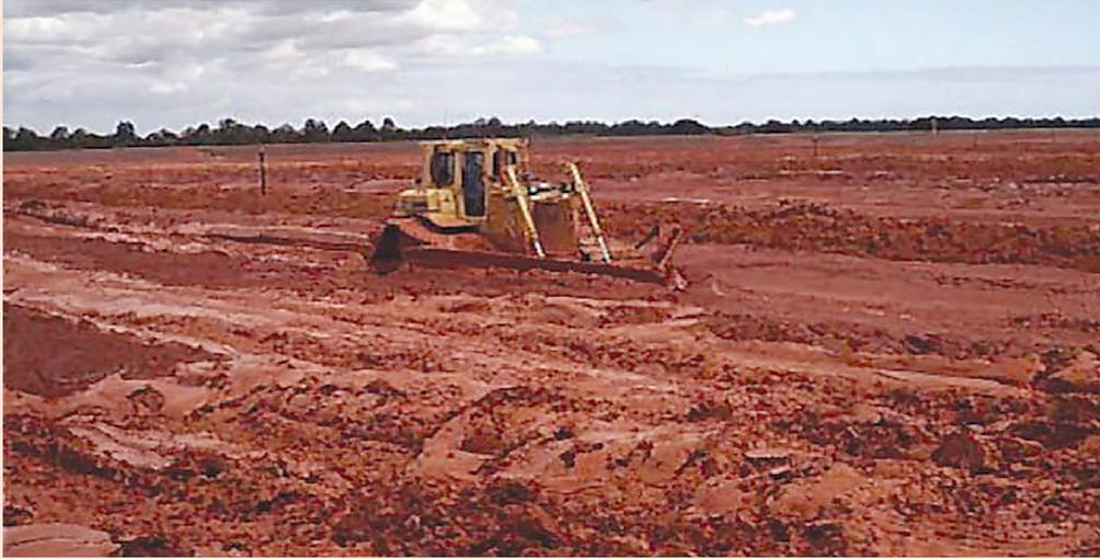
*Utilisation d'un boteur D6 dans un marais afin d'augmenter le taux de séchage*
