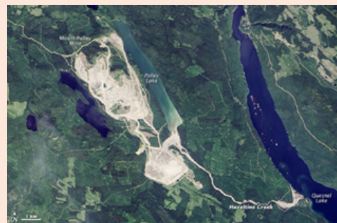
Setelah kebocoran bendungan
