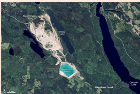
Sebelum kebocoran bendungan
