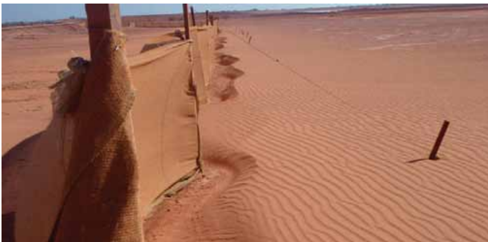
Тоосны нүүдлийг зогсоох Хессийн хашаа. Эх үүсвэр: Жон Виссер, Рио Тинто.
