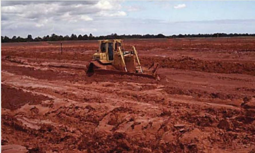
Figura 4.18 Utilización de una excavadora D6 para aumentar la velocidad de secado
