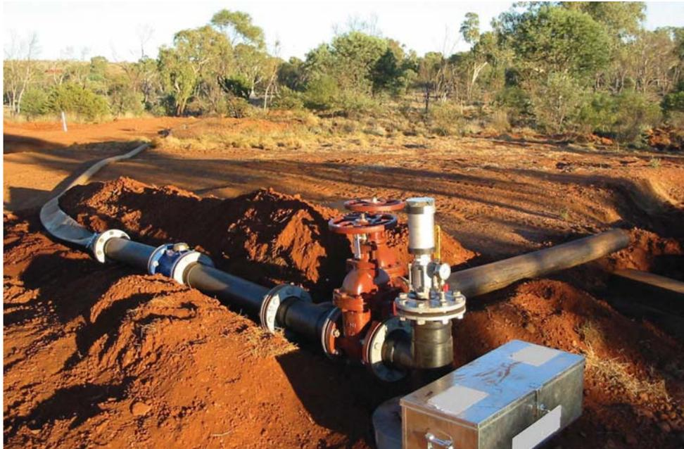
Figura 4.24 Desagüe minero por reinyección de agua en Yandicoogina
