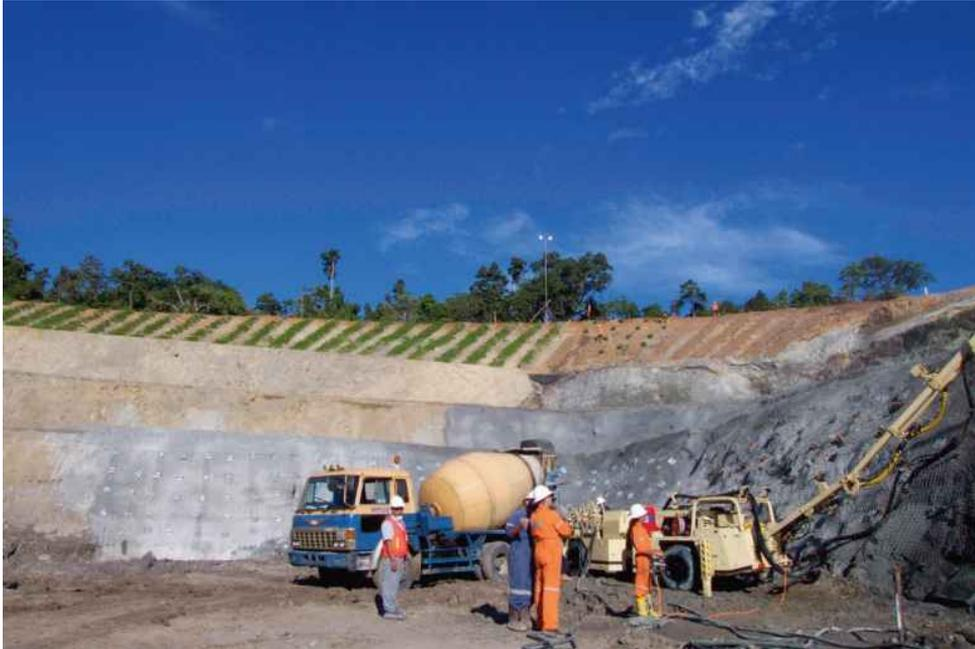
Gambar 1.1 – Rehabilitasi progresif kotak yang terpotong (latar belakang) dalam pembangunan portal (pintu gerbang) di tambang Kencana Newcrest, Indonesia.
